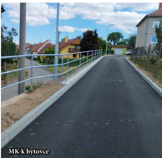
MK k bytovce
